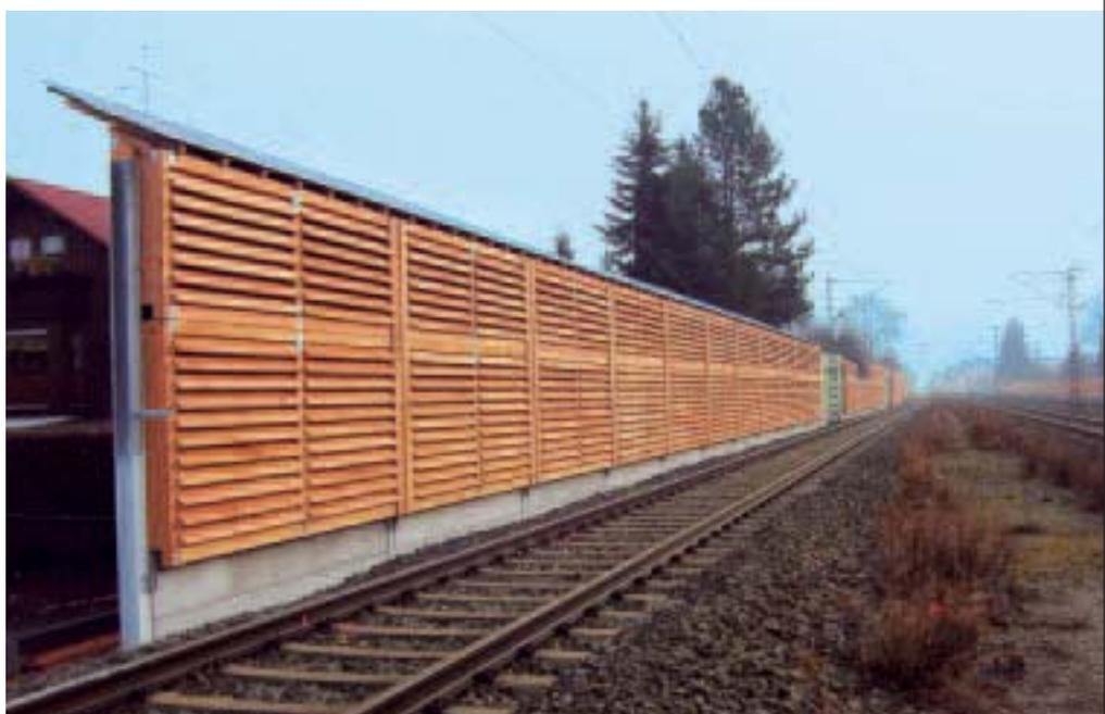
Nachhaltige Baustoffe und zukunftsweisende Technik: Schallschutzwand aus heimischem Lärchenholz mit Fotovoltaikanlage
