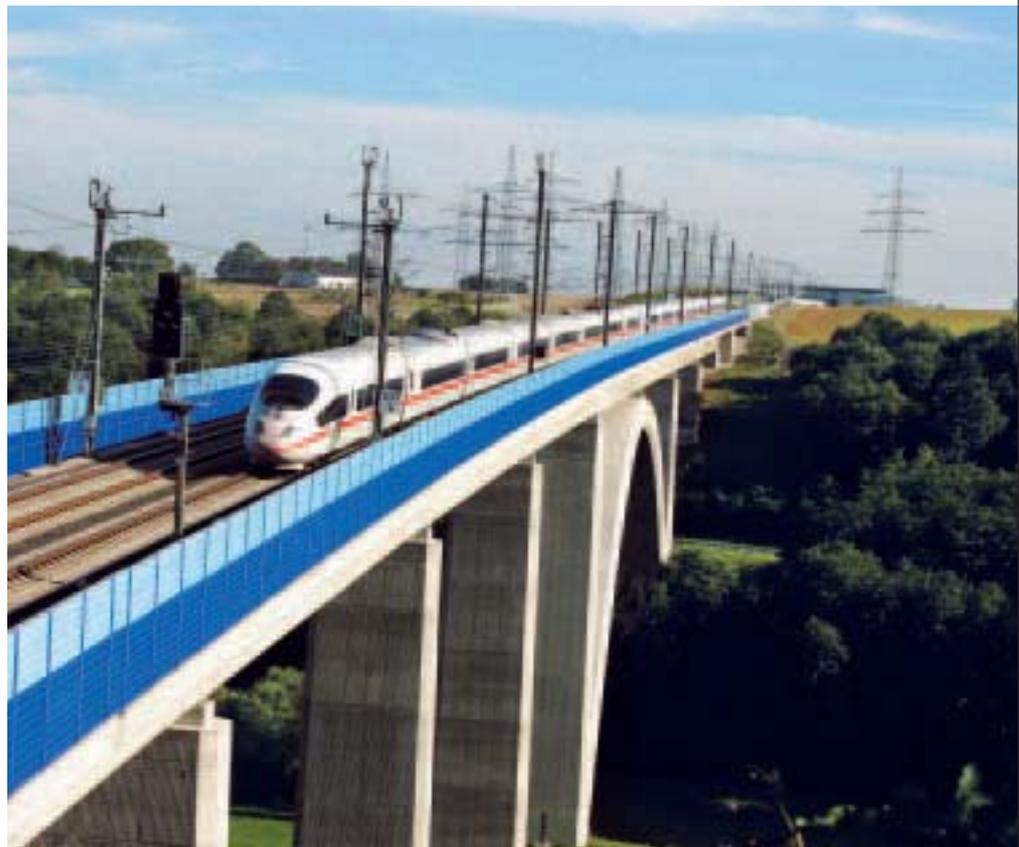
Beispiele für Schallschutzwände
