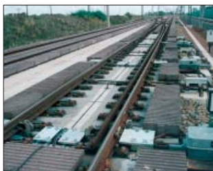
LIAKUSTIK – Schallabsorber im Bereich einer Weiche (FF) auf der Hochgeschwindigkeitsstrecke Berlin – Hannover
