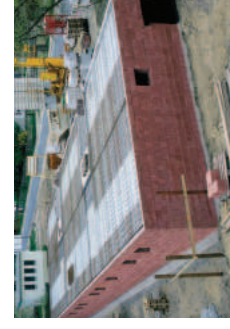
Kellermauerwerk aus LIAPLAN®
