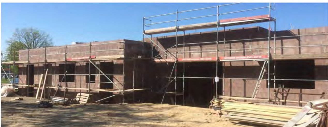
Rohbau: Johanniter-Kindertagesstätte am HELIOS Klinikum Salzgitter
