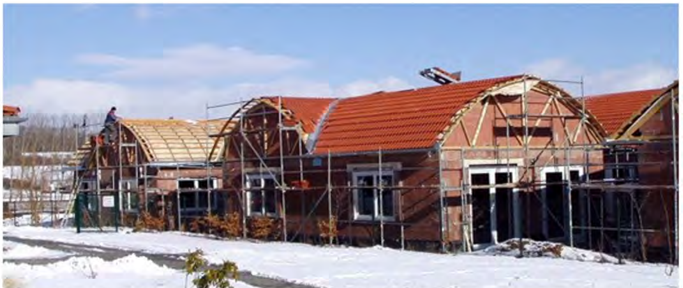
Rohbau: integrativen Kindertagesstätte "Quasselstrippe", lebenshilfe-wernigerode.de
