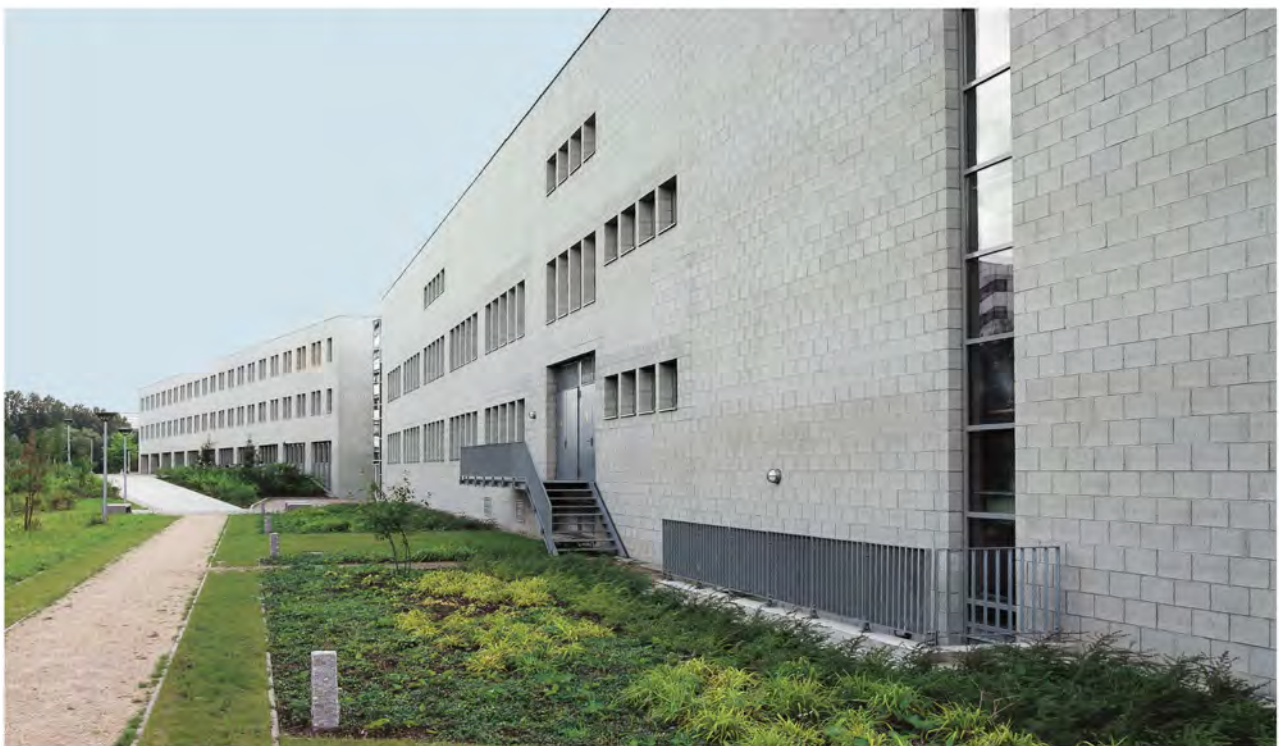
Fassade mit OCTAVANT-Sichtbetonsteinen
